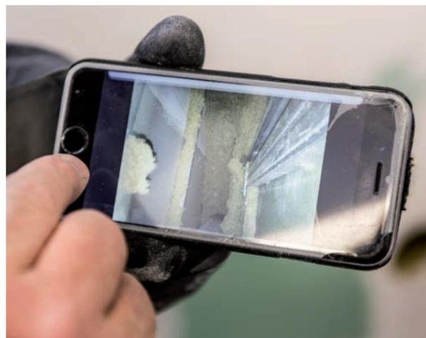
1 Anhand des Innenvolumens der Sanitärwand ermittelt die EBD-Fachfirma die erforderliche Menge Dämmmaterial, welches maschinell über Lanzen in die Sanitärwand mittels Luftbeförderung eingeblasen wird.
